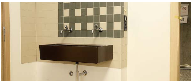
Die Wandplättli sind neu, die Bränneli aus den 70er-Jahren dürfen in den Klassenzimmern bleiben.
