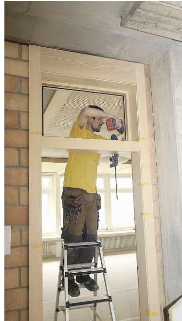
In den Korridoren werden die letzten Deckenplatten montiert und an den neuen Türrahmen die Montage der Türen vorbereitet.
