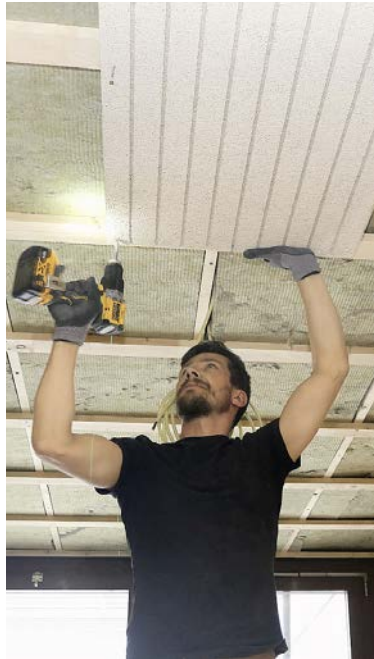
In den Korridoren werden die letzten Deckenplatten montiert und an den neuen Türrahmen die Montage der Türen vorbereitet.
