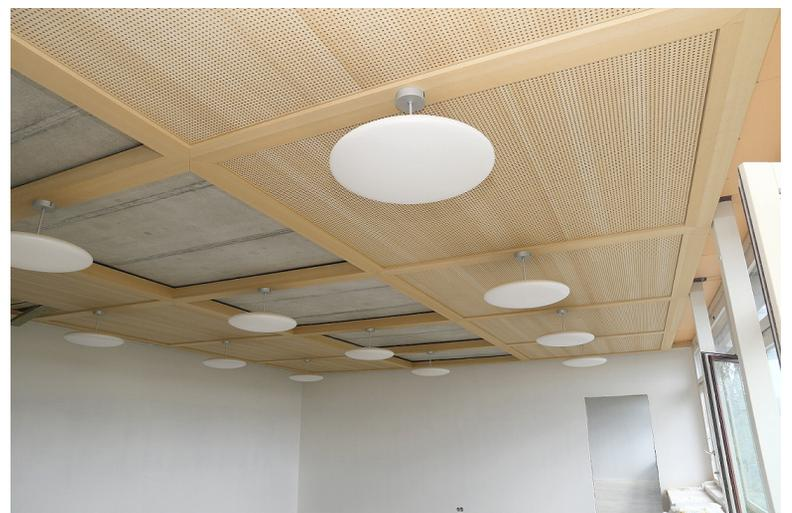
Im Musterzimmer ist die Akustikdecke und die LED-Beleuchtung montiert worden.
