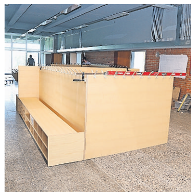
Im Korridor im ersten Stock im Trakt A werden Garderoben montiert.
