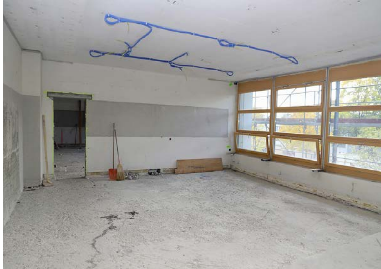
Die Schulzimmer wurden entkernt und teilweise neue Durchbrüche geschaffen. An der Nordseite (Bild rechts) steht die neue gebäudehohe Fensterfront mit dem neuen Zugang bereits.
