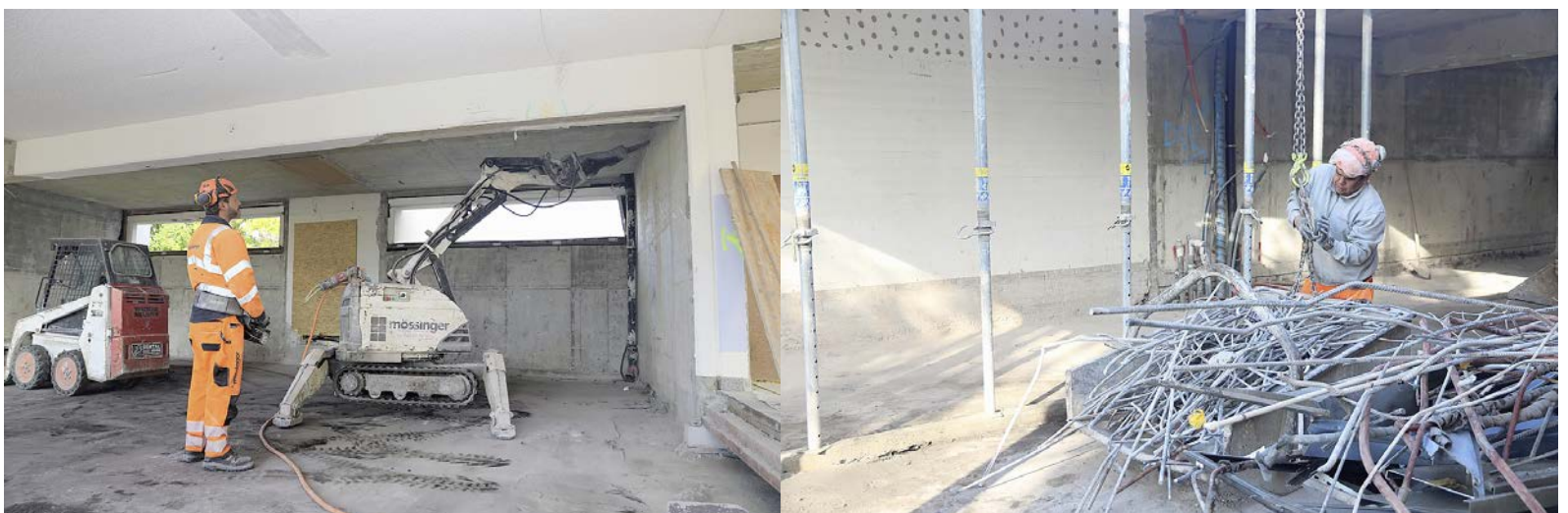
Im vierten Stockwerk des Südtrakts laufen die Abbrucharbeiten sowie die Vorbereitungen für das neue, zentrale Treppenhaus.
