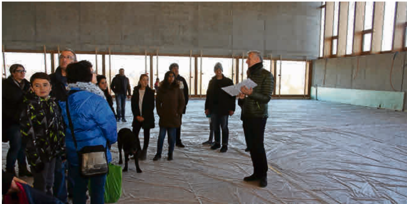
Rundgang im Erweiterungsbau In der Höh. Architekt Detlef Horisberger zeigte am Tag der offenen Baustelle die neue Doppelturnhalle im zweiten Obergeschoss. Bild: Beatrice Zogg
