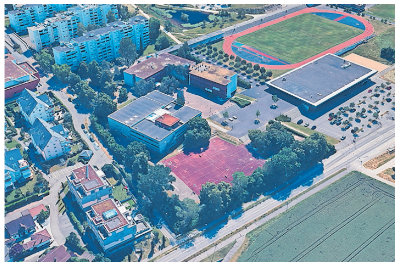
Luftaufnahme, Quelle: Google Maps.
