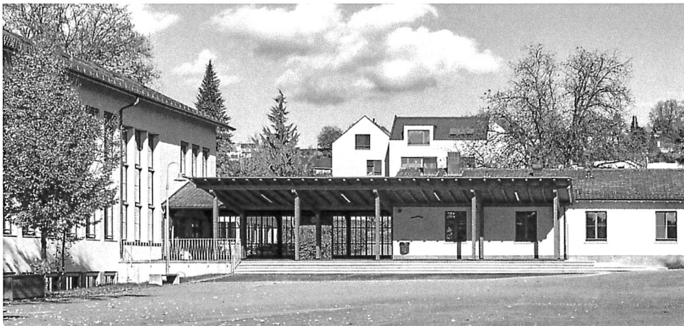
Bild 2: Situation Pausenhallendach angebaut an bestehendes Vordach (Quelle: Eglin Partner Architekten)
