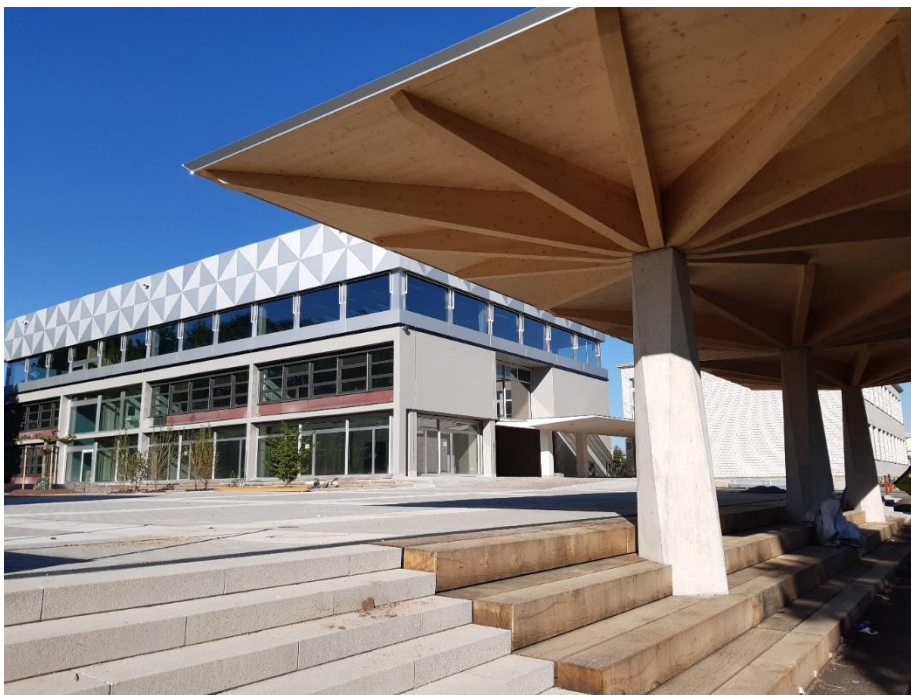
Trakt A mit Aufstockung, gedeckter Pausenplatz
