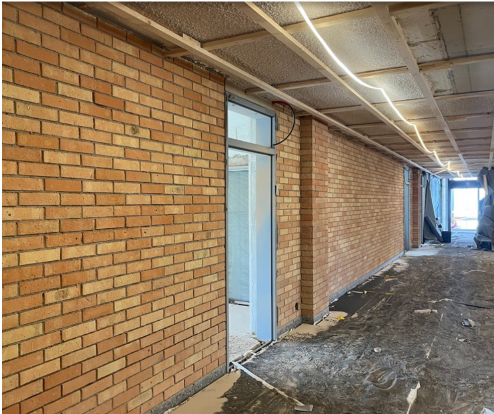
Die übermalten Backsteinmauern wurden sandgestrahlt und zeigen sich nun wieder in ihrem ursprünglichen Zustand.
