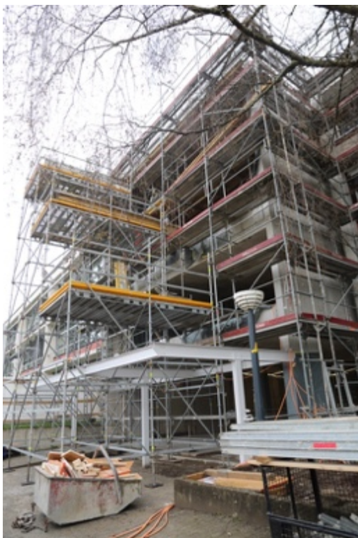
Über dem Haupteingang sieht man bereits die neuen Räume im Rohbau.
