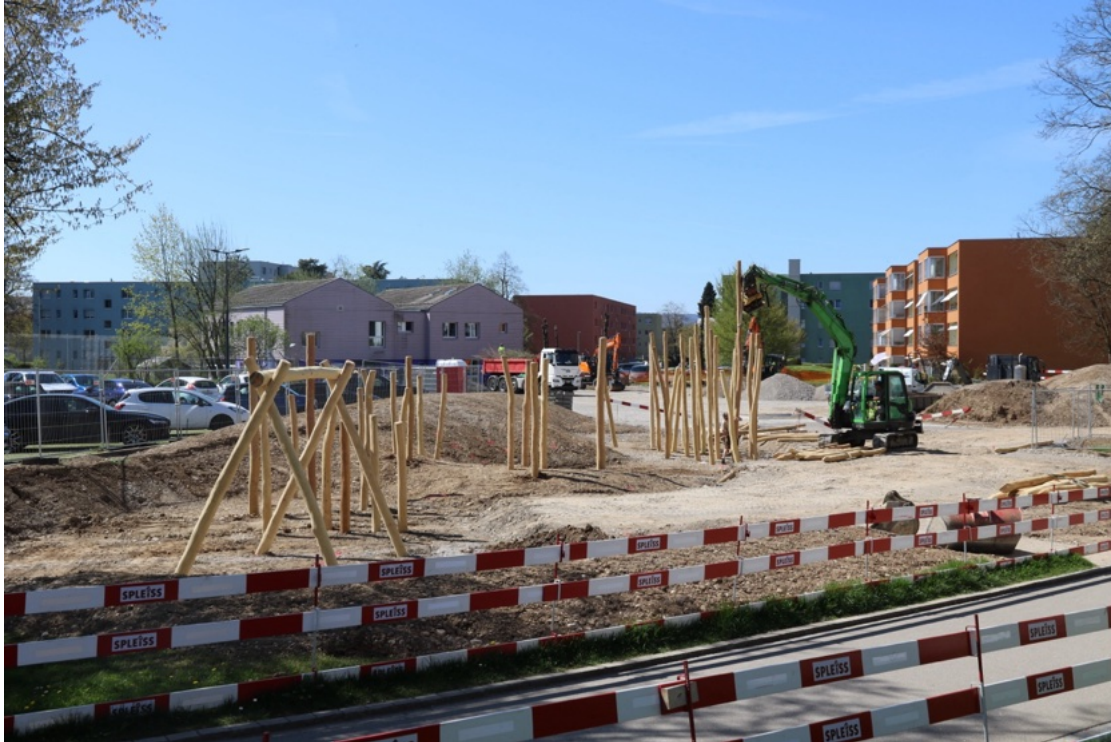
Am Mittwoch, 8. April 2026, standen bereits erste Elemente für den neuen Spielplatz beim «Feldhof». Im hinteren Bereich wird je ein Spielfeld für Basketball und Fussball erstellt. Bilder: Beatrice Zogg
