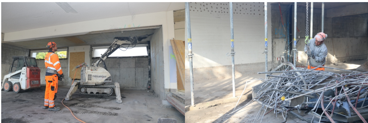
Im vierten Stockwerk des Südtrakts laufen die Abbrucharbeiten sowie die Vorbereitungen für das neue, zentrale Treppenhaus. Fotos: Beatrice Zogg
