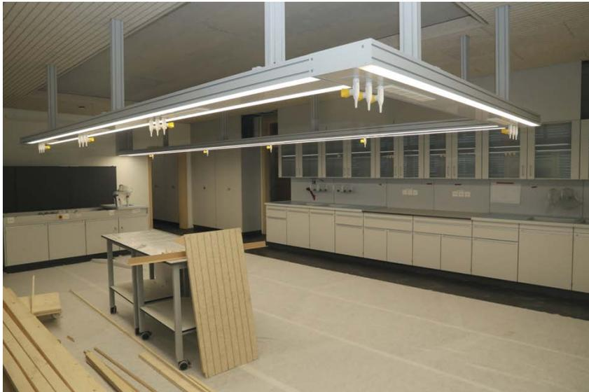
Der an der Decke befestigte Medienbalken in den beiden Chemie-/Physikzimmern ermöglicht ein flexibles Arbeiten mit Gas und Elektrogeräten.
