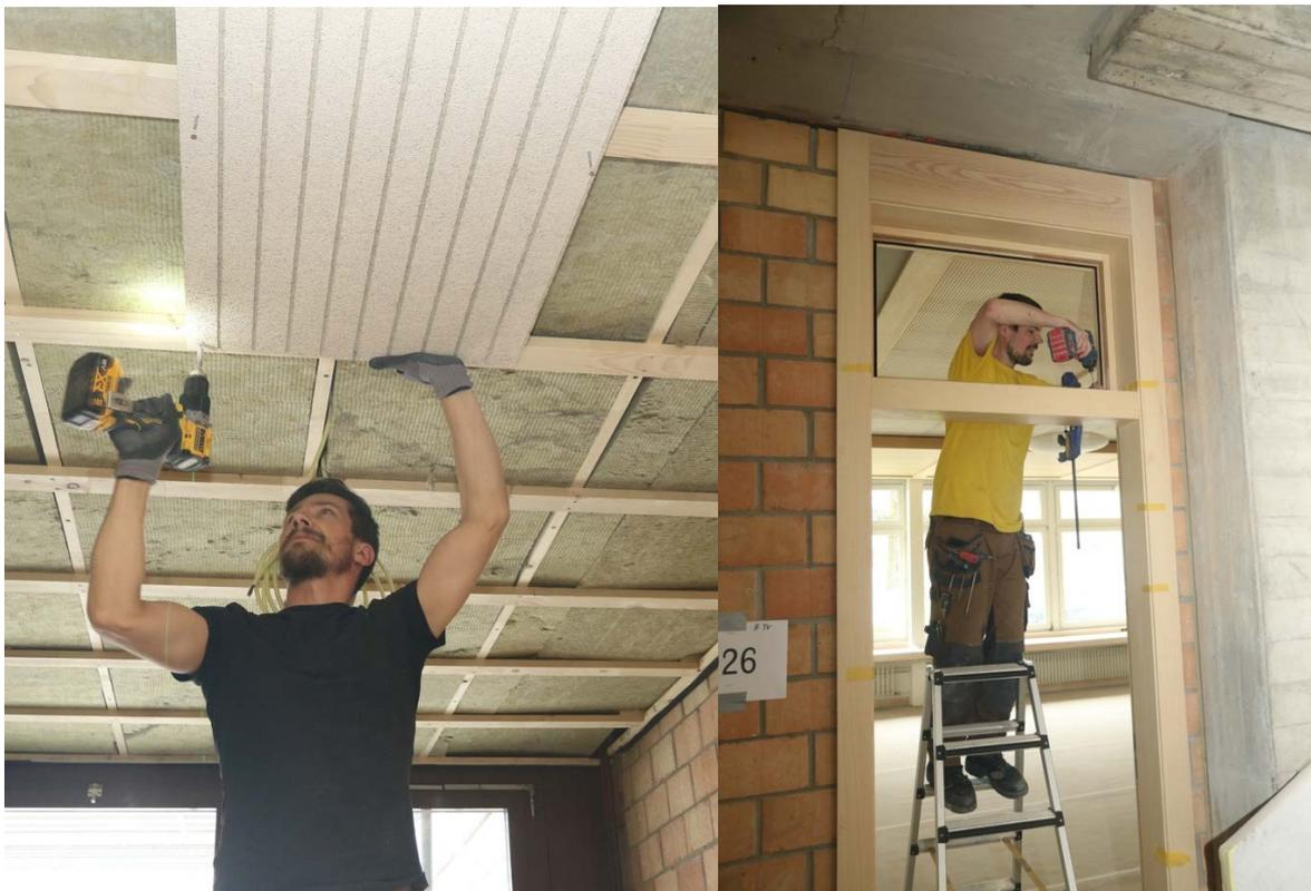
In den Korridoren werden die letzten Deckenplatten montiert und an den neuen Türrahmen die Montage der Türen vorbereitet.
