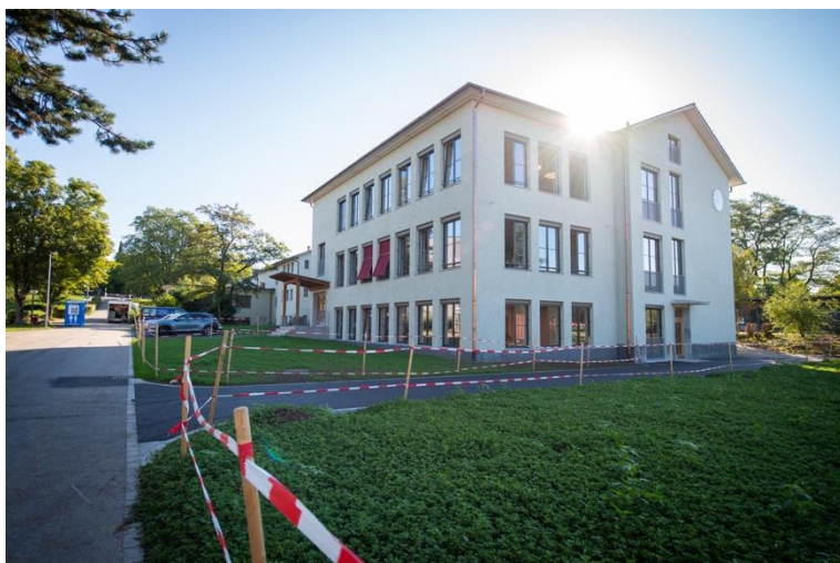
Der neue dreistöckige Anbau auf der Rückseite des Schulgebäudes. Fotos: Seraina Boner
