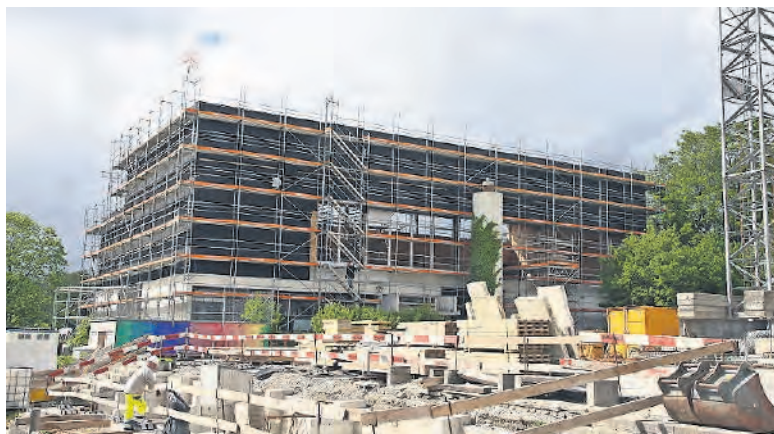
Einer der beiden Richtbäume wurde auf der neuen, aufgestockten Turnhalle montiert.
