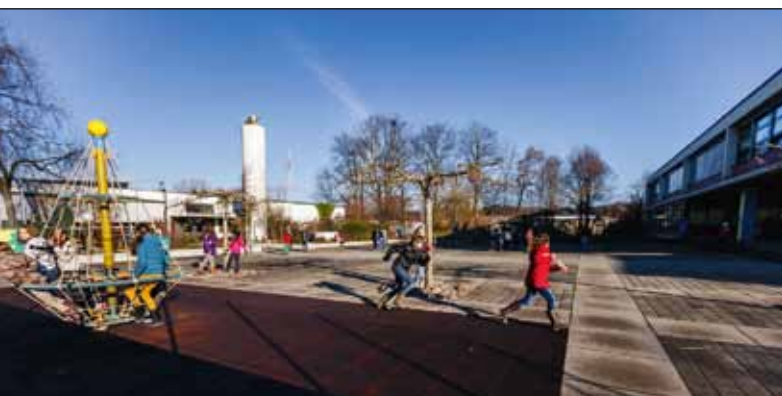
Die Trakte C (links) und A werden aufgestockt – dadurch bleibt der grosszügige Pausenplatz erhalten.
