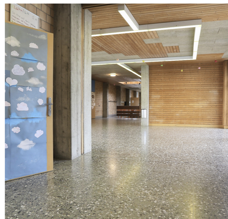
Die grossen Korridorzonen können heute gemäss Brandschutzvorschriften nicht als zusätzliche Lernorte genutzt werden. Dank dem Bau von zwei neuen Fluchttreppen ist dies zukünftig möglich.
