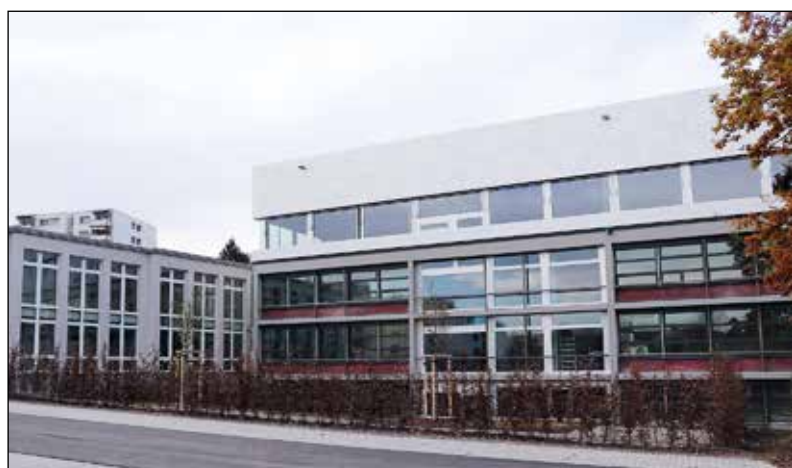
Blick von der Riedstrasse auf den aufgestockten Trakt A. Links hinten der Trakt B von 1997.
