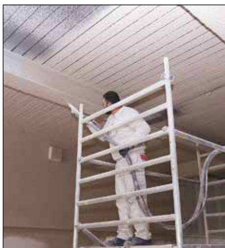
An der Decke im Gang wird der Spritzguss angebracht.
