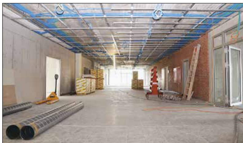
Blick in den Eingangsbereich im Trakt A: Viel mehr Platz, da die Treppenanlage versetzt worden ist.
