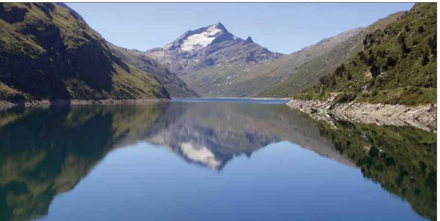
Der Lago di Lei ist ein acht Kilometer langer Stausee, der fast vollständig in Italien liegt. Nur die 141 Meter hohe Staumauer und der 950 Meter lange Zufahrtstunnel liegen in der Schweiz.
