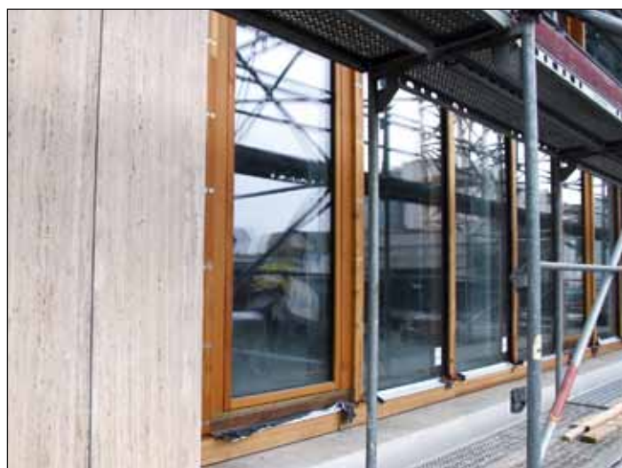
Wie beim bestehenden Schulhaus wird auch beim Neubau für die Fassade teilweise Travertinstein verwendet. Auch die Fensterrahmen sind wie beim bestehenden Bau aus Holz.
