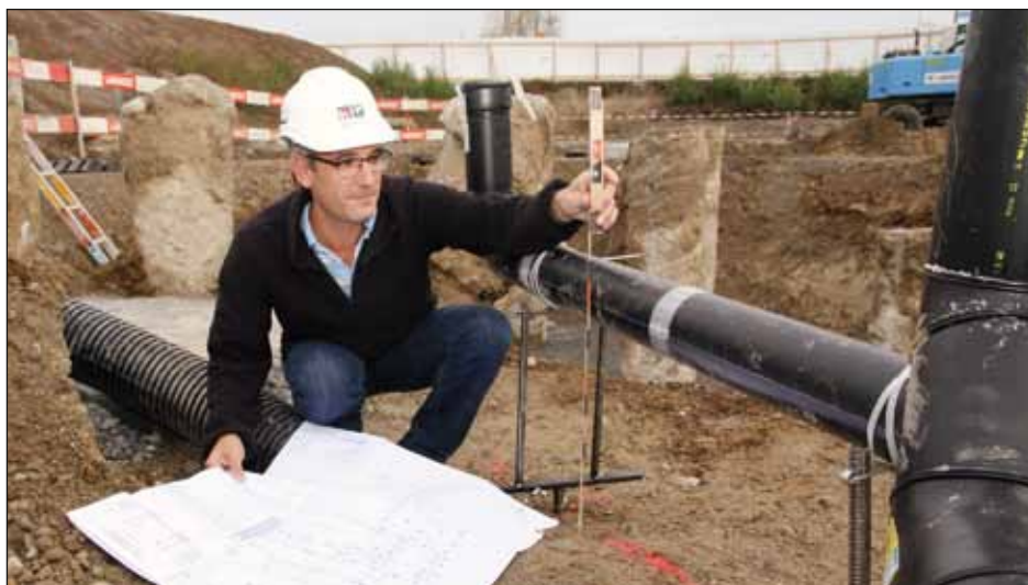
Noch ohne Schnee: Baustellenleiter Beat Eugster kontrollierte im November die verlegten Kanalisationsrohre.
